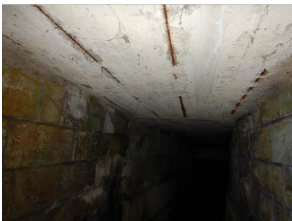
Foto 11: Odhalená výztuž ve stropních deskách
