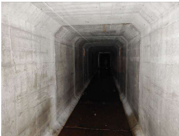
Foto 15: Železobetonové rámy
