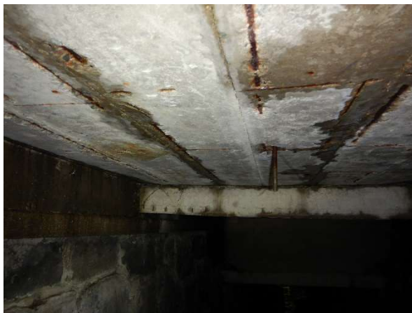
Foto 3: Odhalená výztuž stropních desek
