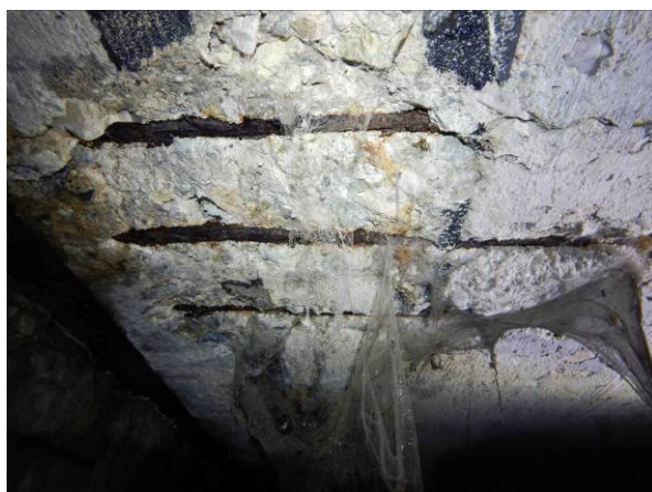
Foto 12: Detail odhalené výztuže
