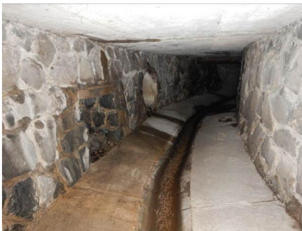
Foto 9: Betonové dno koryta
