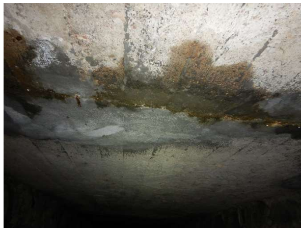
Foto 6: Drobné průsaky v místě sanace
