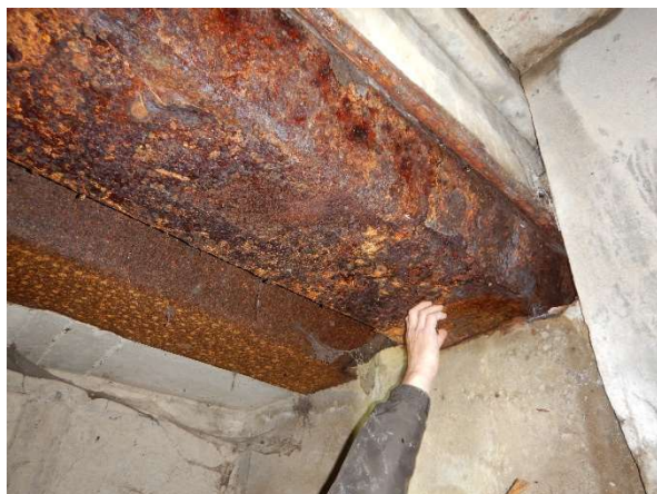
Foto 14: Odlupující se části zkorodovaných štětovnic
