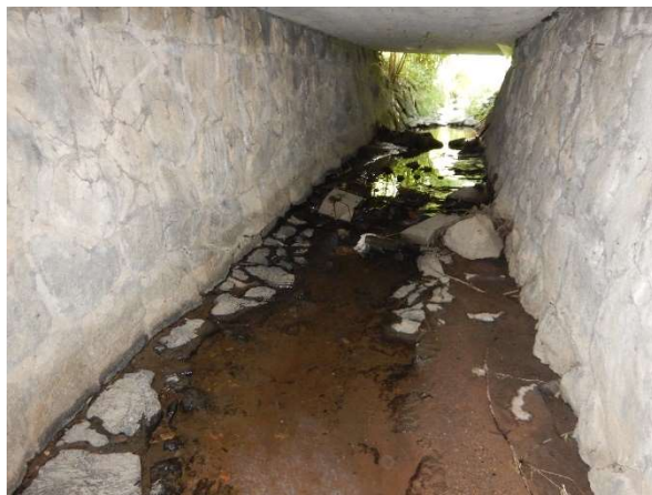
Foto 16: Kamenné dno koryta a opěrné zdi
