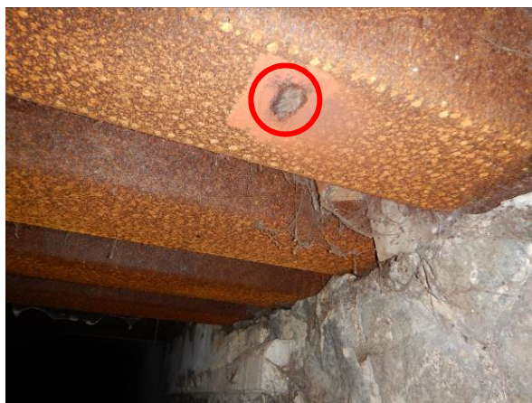
Foto 18: Zbroušená plocha 3. nosníku
