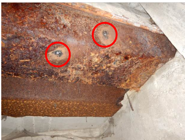
Foto 17: Zbroušené plochy 1. nosníku
