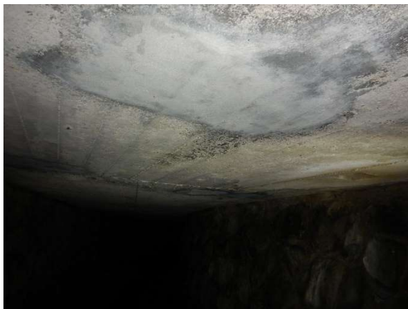
Foto 5: Sanace stropu stěrkou bez projevu průsaků a boulení
