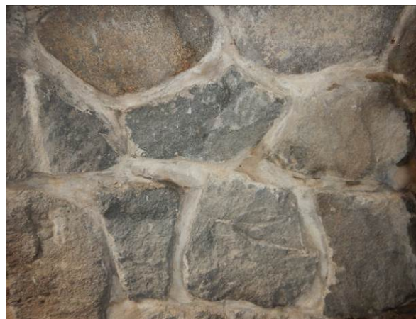
Foto 10: Spárování opěrné zdi
