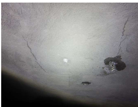
Foto 7: Sanace stropu s mírnými projevy deformací a lokálních průsaků
