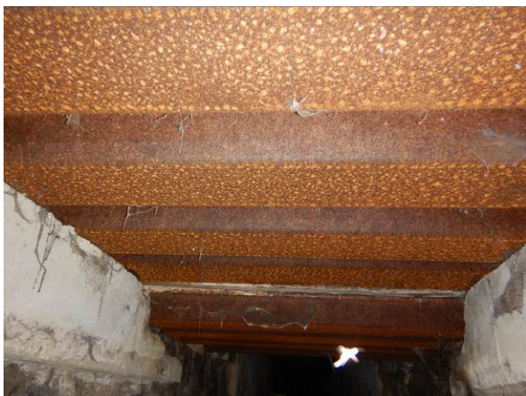
Foto 13: Štětovnice v místě přemostění
