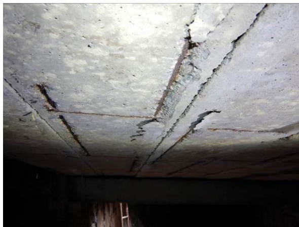
Foto 4: Degradace betonu v okolí výztuže
